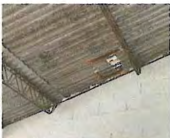
Foto 1: Las láminas se encuentran picadas y quebradas lo que provoca filtración de agua en algunas aulas. Produciendo que el mobiliario se deteriore.
