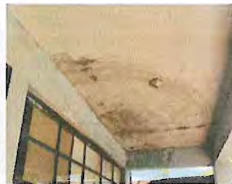
Foto 2: La humedad de la terraza se filtra y provoca constantes goteras en el interior de las aulas, lo cual causa daños al mobiliario y a los recursos didácticos.
