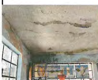
Foto 2: La humedad de la terraza se filtra y provoca constantes goteras en el interior de las aulas, lo cual causa daños al mobiliario y a los recursos didácticos.
