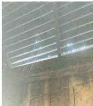
Foto 1: Las láminas se encuentran picadas y quebradas lo que provoca filtración de agua en algunas aulas. Produciendo que el mobiliario se deteriore.
